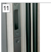
Przegroda termiczna, dwie uszczelki w ościeżnicy
